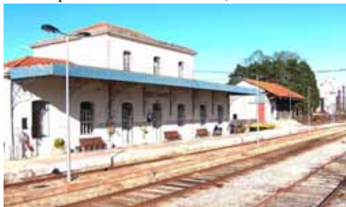
Figura 6 – Estação ferroviária da Cidade de Cantanheda
