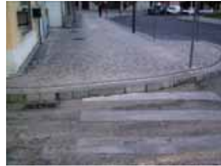
Figura 19 – Inexistência de rampa numa passadeira na Praça Marquês de Marialva
