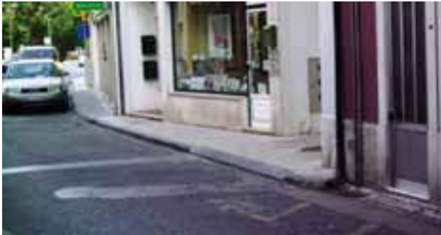
Figura 18 – Largura irregular dos passeios, Rua Arcebispo Primaz
