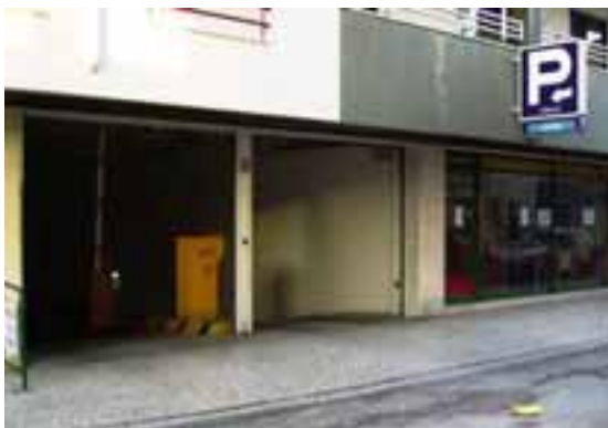
Figura 9 – Parque de estacionamento subterrâneo, Rua Henrique Barreto
