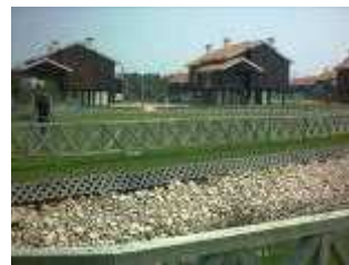
Fig. 8 – Construções recentes com traços semelhantes aos Palheiros da Praia da Tocha
