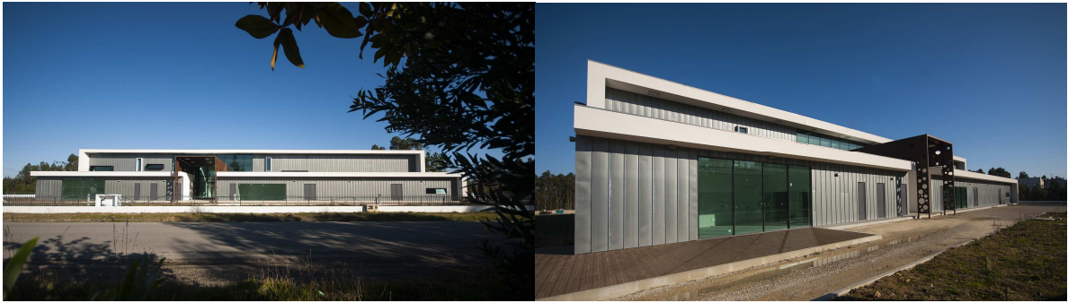
Fig. 5 – Vista geral da unidade industrial existente, com uma imagem arquitetónica perfeitamente enquadrada na envolvente
