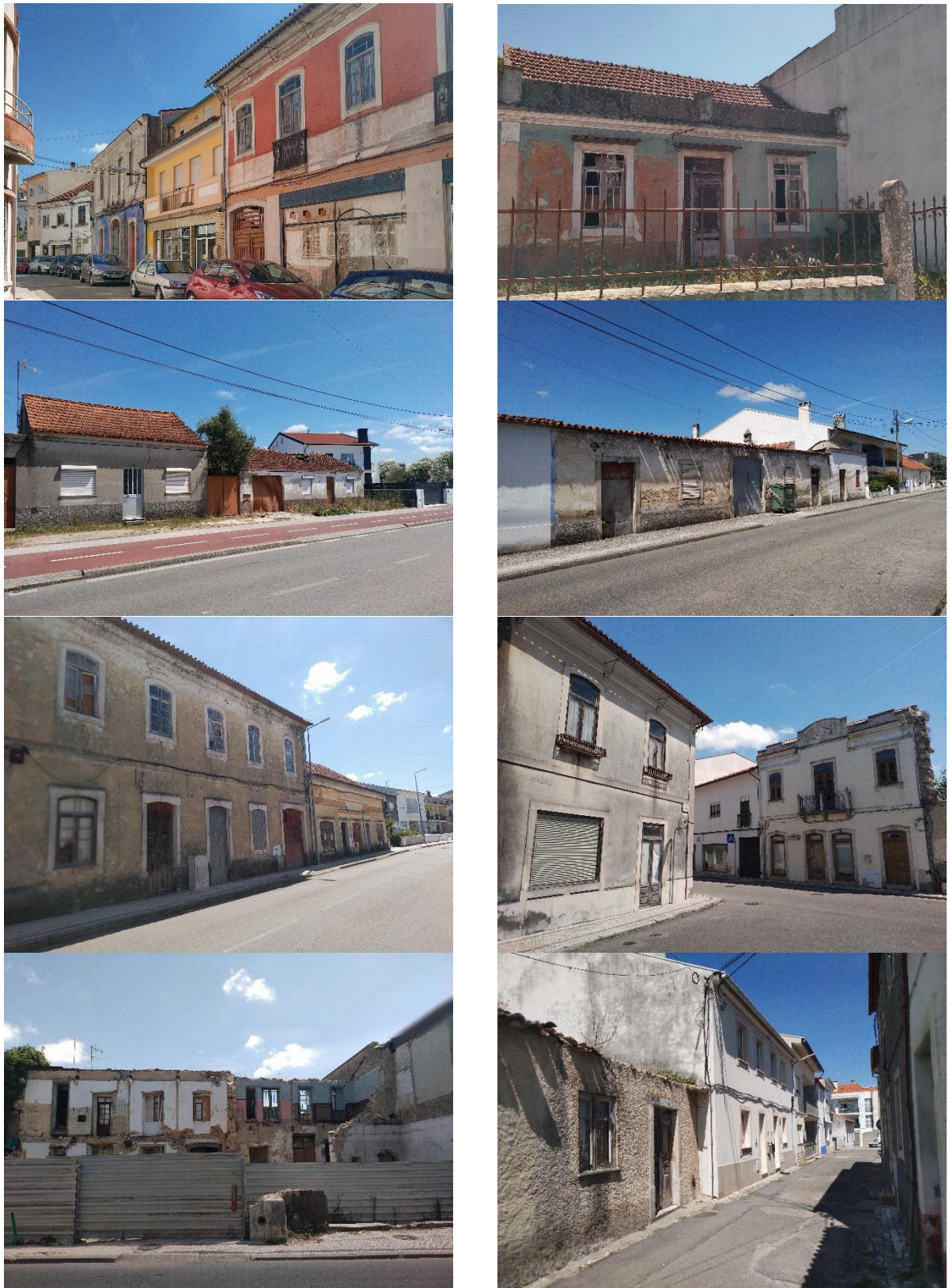
Figura 4. Exemplos do estado de conservação do edificado da ARU da Cidade de Cantanhede
