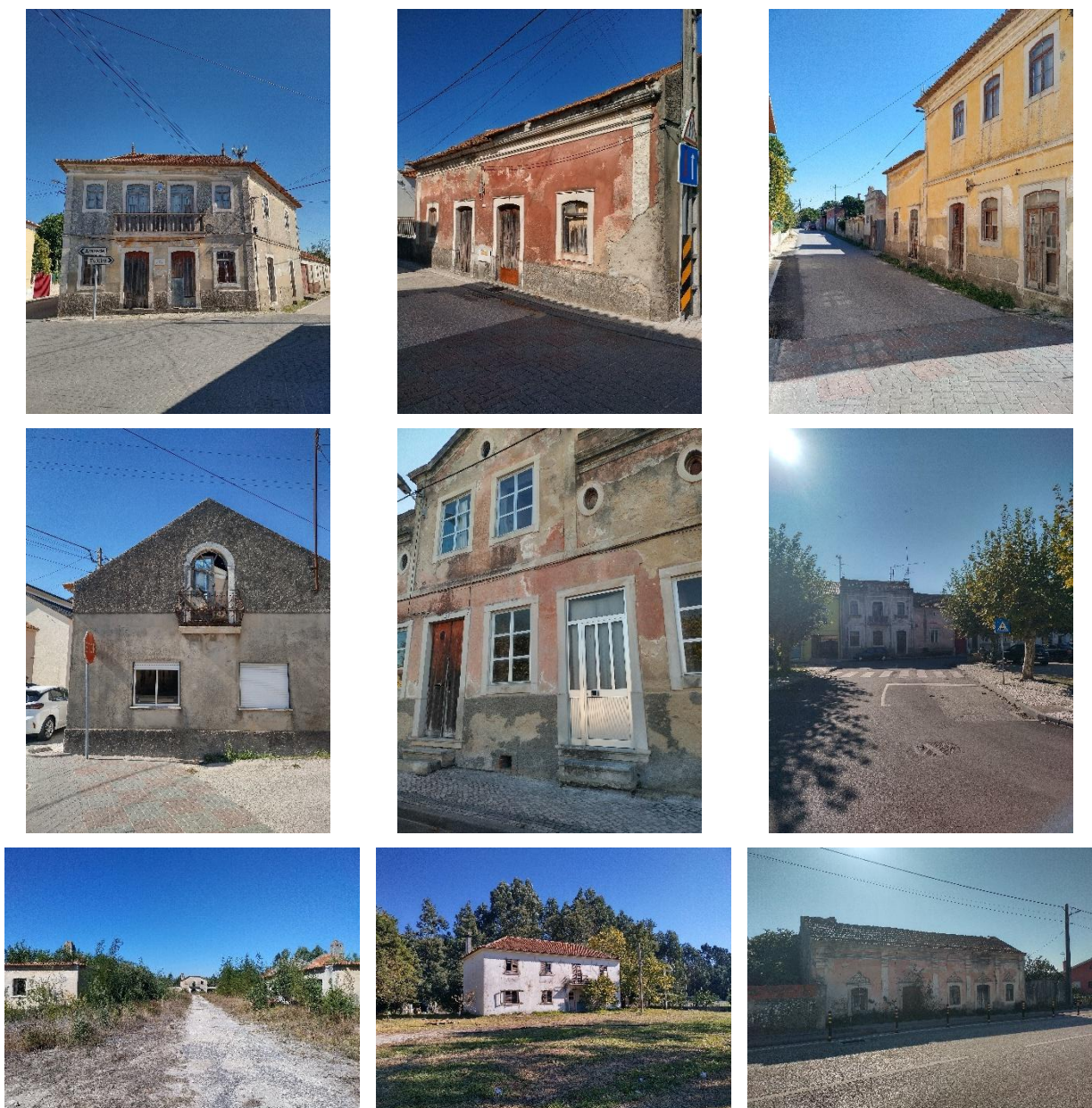
Figura 10. Exemplos de edifícios com necessidade de reabilitação
