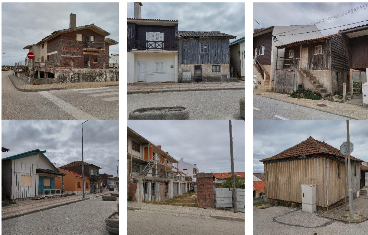
Figura 11. Exemplos de edifícios com necessidade de reabilitação
